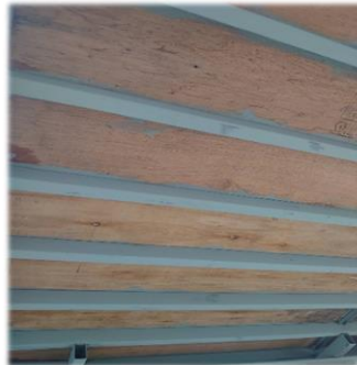
床骨格の錆止め
