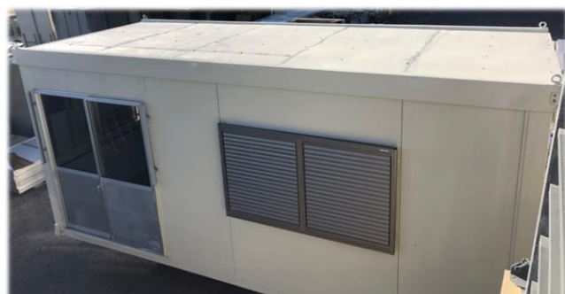
屋根の張り替え
