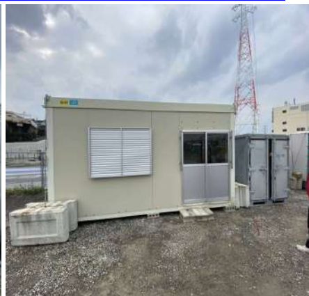
ハウスと倉庫を片側1個の トングブロックで固定したケース
