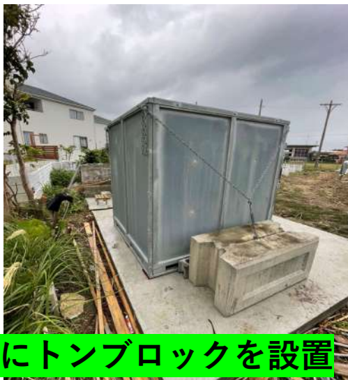
ハウスと倉庫を片側1個の トングブロックで固定したケース
