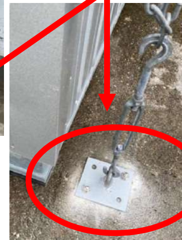
スペースの都合で トングブロックが 置けない場合は アンカー工事も 対応可の場合も。
